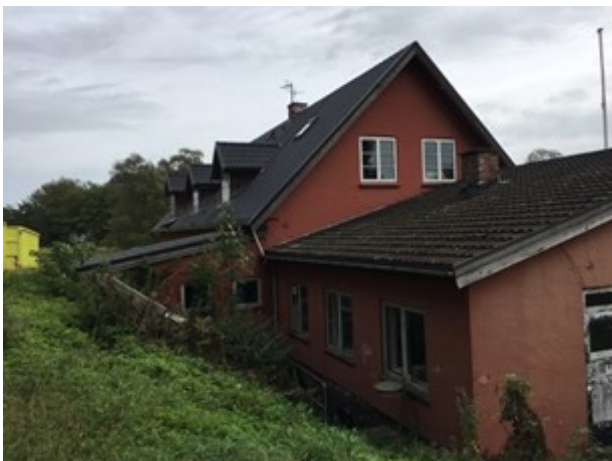
Den eksisterende krobygning set fra Hulerødvej. Eksisterende bygninger set fra nordvest.
