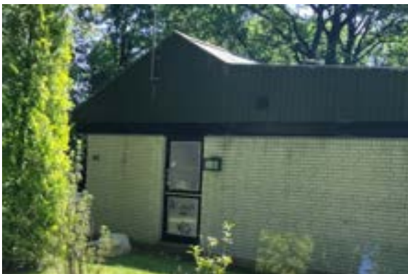
Tvingsbakken 40 Usædvanlig gavlforn
