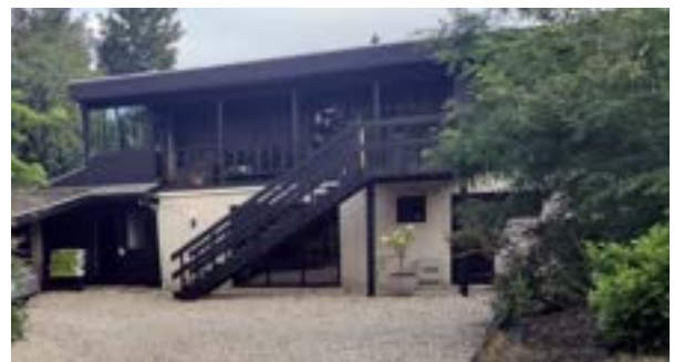
Granvej 18 Mere end en etage Facadehøjde over 3,8 m
