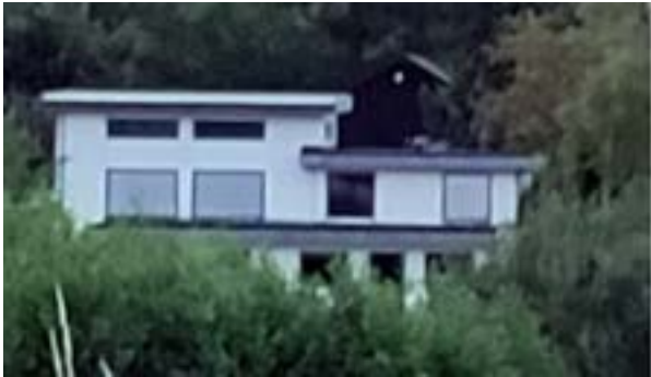
Granvej 22 Mere end en etage Facadehøjde over 3,8 m
